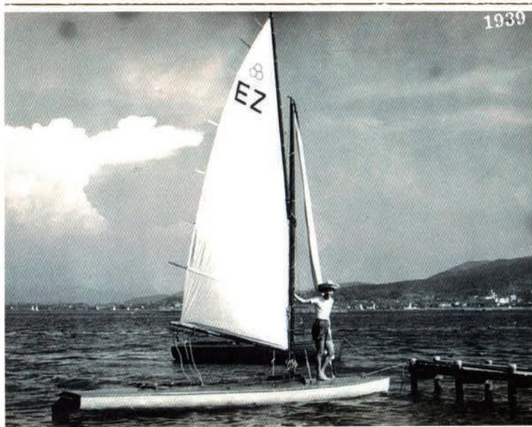
ドイツから取り寄せた設計図に基づいて、1939年に桑野造船所で建造されたEZ級の木造船ディンギー。（SVARA（スワラ）と名付けられた
