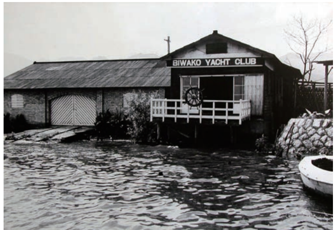
再建されたBYC艇庫
